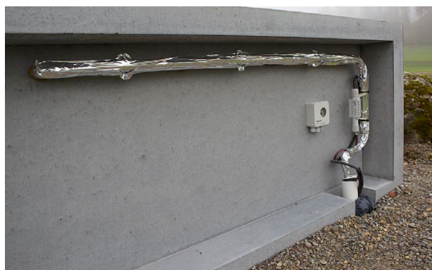
Paroi arrière du modèle «résistant au gel», après l'installation des pièces sanitaires, avant la pose du matériel isolant et de la fixation de la paroi arrière. Ces travaux sont exécutés sur site par un spécialiste en sanitaires à mandater.
