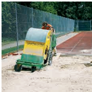
Entrée dans l'installation
