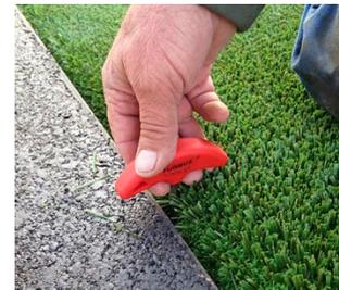
Das Befestigungselement wird über die Rundung um 90° abgedreht und der Einbauschlüssel herausgezogen.
