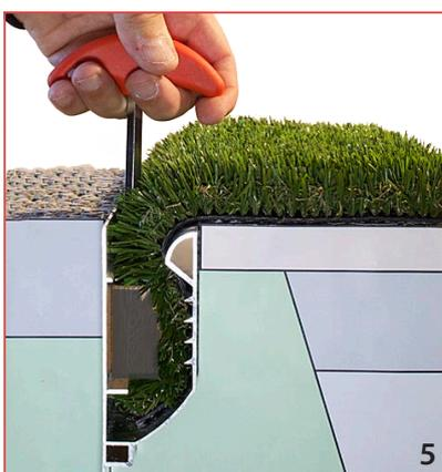
5 Nach der Einführung bis zum Arretierungssteg wird das Element um 90° gedreht. Anschließend wird der Einbauschlüssel angehoben. Die Fixation, welche im Abstand von ca. 50 cm vorgenommen wird, gewährleistet, dass der Kunstrasen den Zugkräften standhält.
