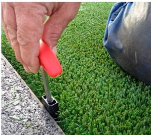
Das Befestigungselement wird mittels Einbauschlüssel in das Einbauelement, bis zum unteren Steg, eingefügt (beachten Sie die Bilder auf der vorangehenden Seiten).
