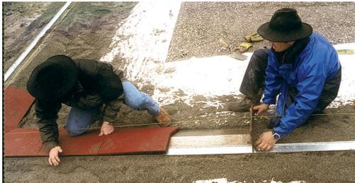
Die personelle Idealbesetzung für diese Arbeiten sind zwei Personen. Eine Person erstellt die Planie der Unterlagsschicht mit der Schablone und eine Person verlegt die Umrandungselemente. Auf allen vier Seiten muss ein Element eingepasst werden. Der Zuschnitt kann mit einer Stichsäge erfolgen. Auf einer Seite wird diese Platte im Steckverbund mit der Nachbar-Platte fixiert und auf der anderen Seite mit dem mitgelieferten PU-Kleber (Kartusche) verklebt.
