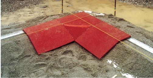
Die Versetzarbeiten werden in einer Ecke begonnen mit dem Eckelement. In die verlegte Gummi-Granulatplatten werden die Steckverbindungen angebracht. So ist ein optimaler Verbund zwischen den Elementen gewährleistet.
